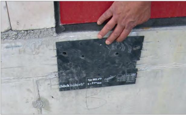
Abb. 1: Nachdem die richtige Position für den Anschluss ermittelt wurde, werden die Bohrlöcher mit Hilfe einer Schablone angezeichnet.
