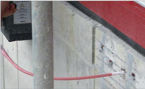
Abb. 5: Die Bohrlöcher werden mit Injektionsmaterial gefüllt. © Schöck
