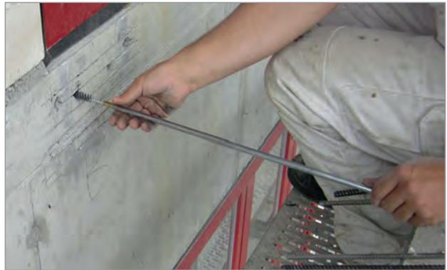
Abb. 4: Die Bohrlöcher werden ausgebürstet, um die Oberfläche aufzurauen und ausblasen, um das Bohrmehl zu entfernen.
