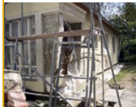
Zum Ziel, eine luftdichte Gebäudehülle zu schaffen, tragen auch die neuen Kunststofffenster mit ihren guten Werten ihren Teil bei.
